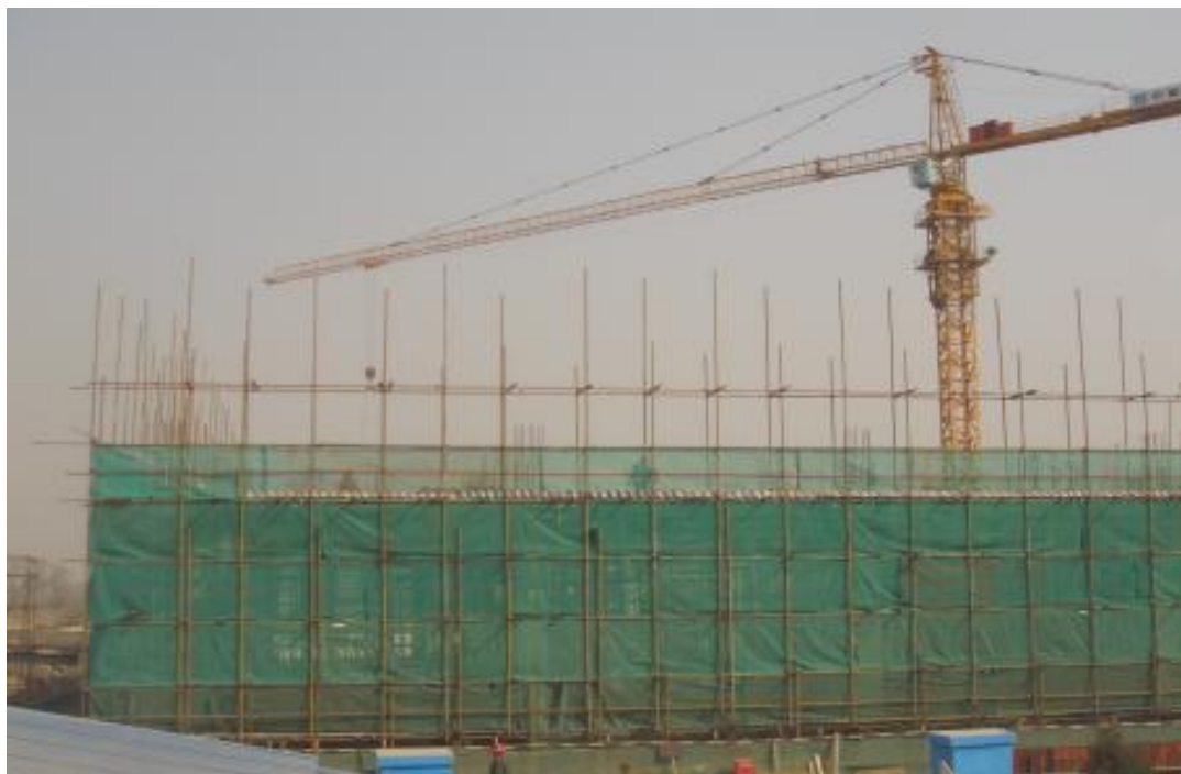
中央财经大学沙河新校区主教学楼施工现场
